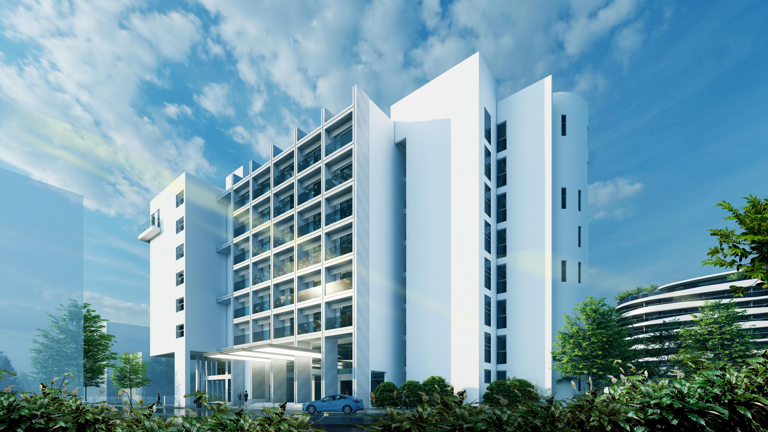
PHỐI CẢNH GÓC NHÌN TỪ CÔNG KHU 1
